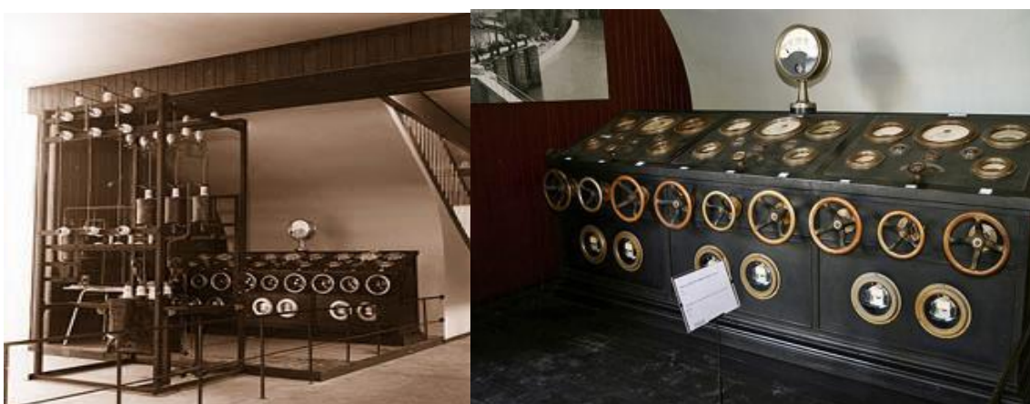
Sl.1.3 - Upravljački pult hidrocentrale Ozalj, izgrađen 1908. godine (Izvor: www.mdc.hr/tehnicki/hr/03-energija/03-energija-10.htm )
